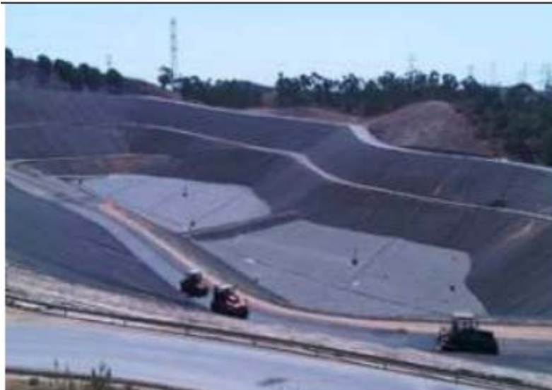
Figura 15 – Aplicação de geomembrana em obra de impermeabilização de aterro sanitário
