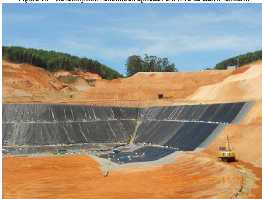
Figura 10 - Geocomposto bentonítico aplicado em obra de aterro sanitário
