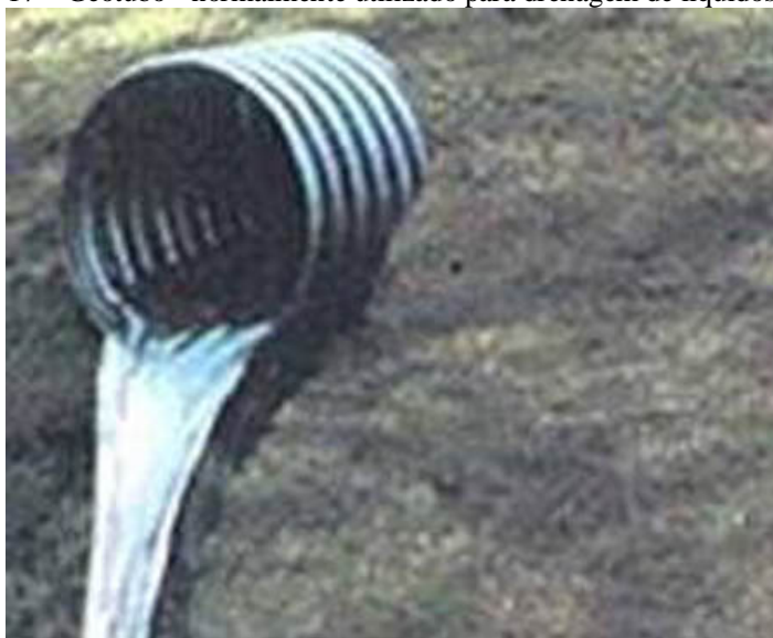
Figura 17 – Geotubo - normalmente utilizado para drenagem de líquidos e gases
