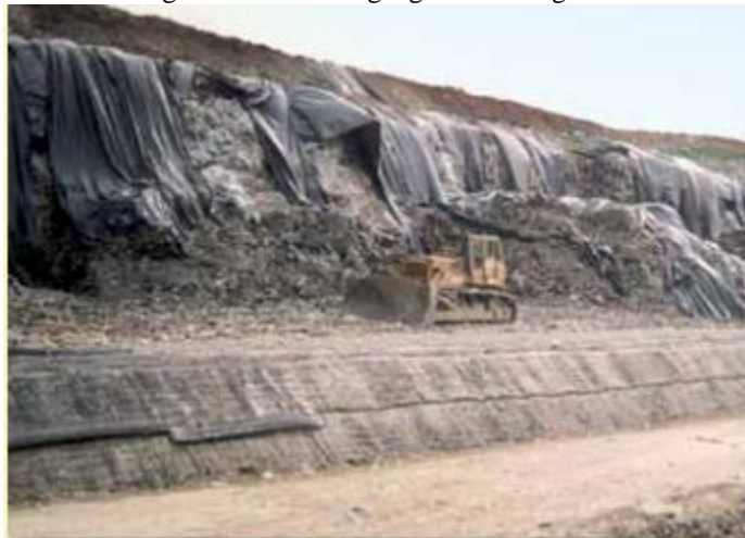
Figura 13 – Uso de geogrelhas Macgrid®
