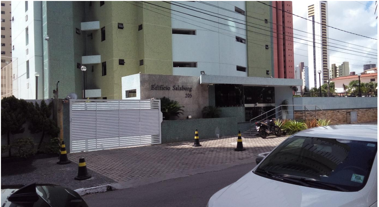
Imagem 12 - Vizinhança Imediata ao ECO Medical Composta por Residências Multifamiliar
