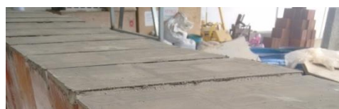
Figura 21 - Capeamento dos prismas
