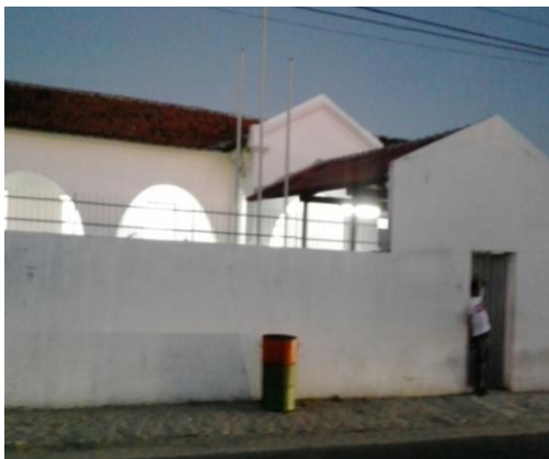
Figura 01 – Visão geral da fachada da Escola Fonte: S. B. de Lima
