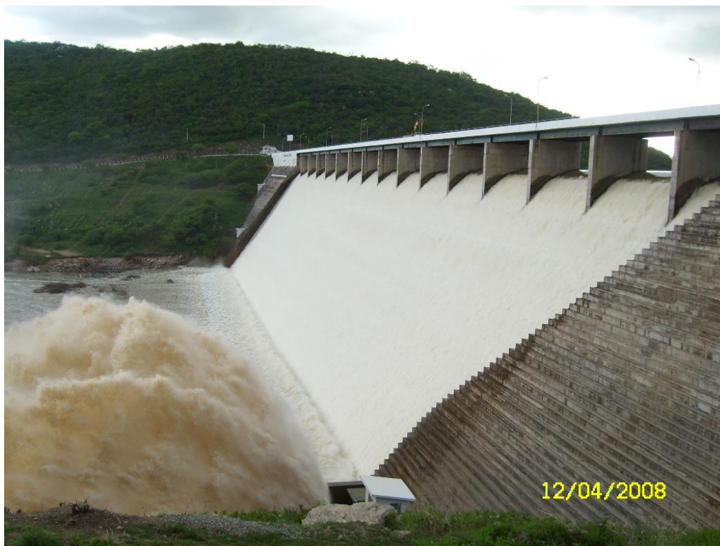
Figura 3: Parede da barragem Argemiro de Figueiredo, Acauã.
