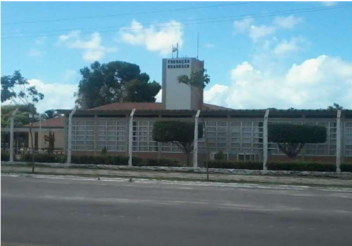
Figura 6: Centro Educacional Fundação Bradesco Samuel Santana. Maio de 2017.
