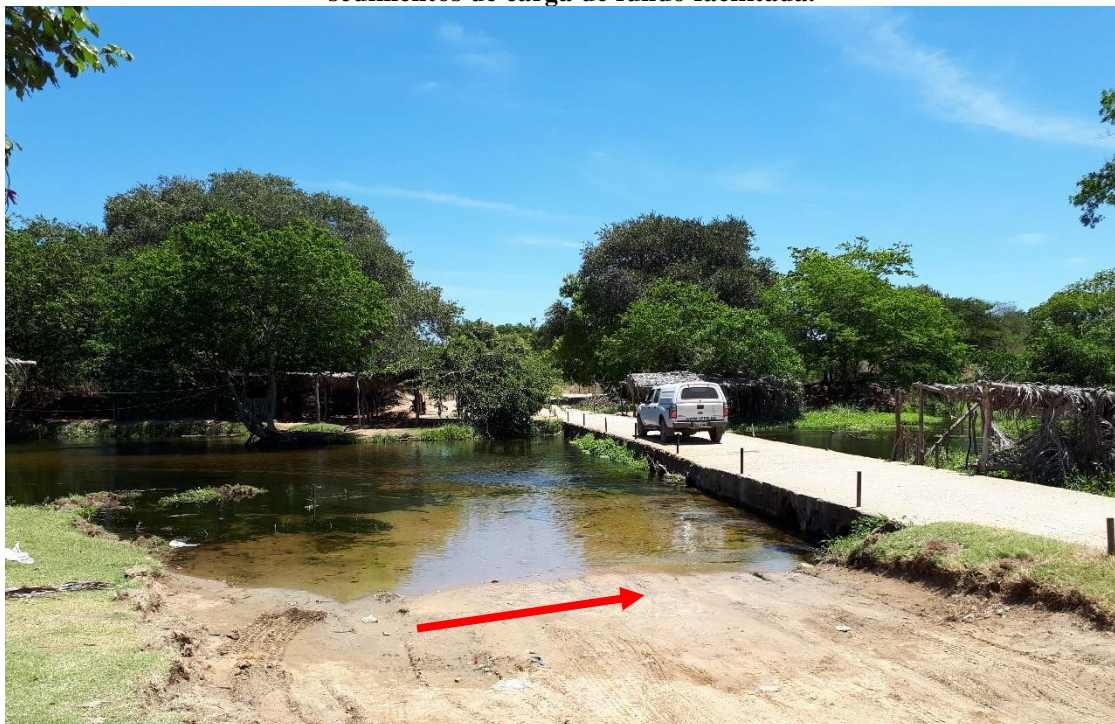
Figura 22. Passagem molhada no canal perenizado do Rio Piancó, com transmissão de sedimentos de carga de fundo facilitada.
