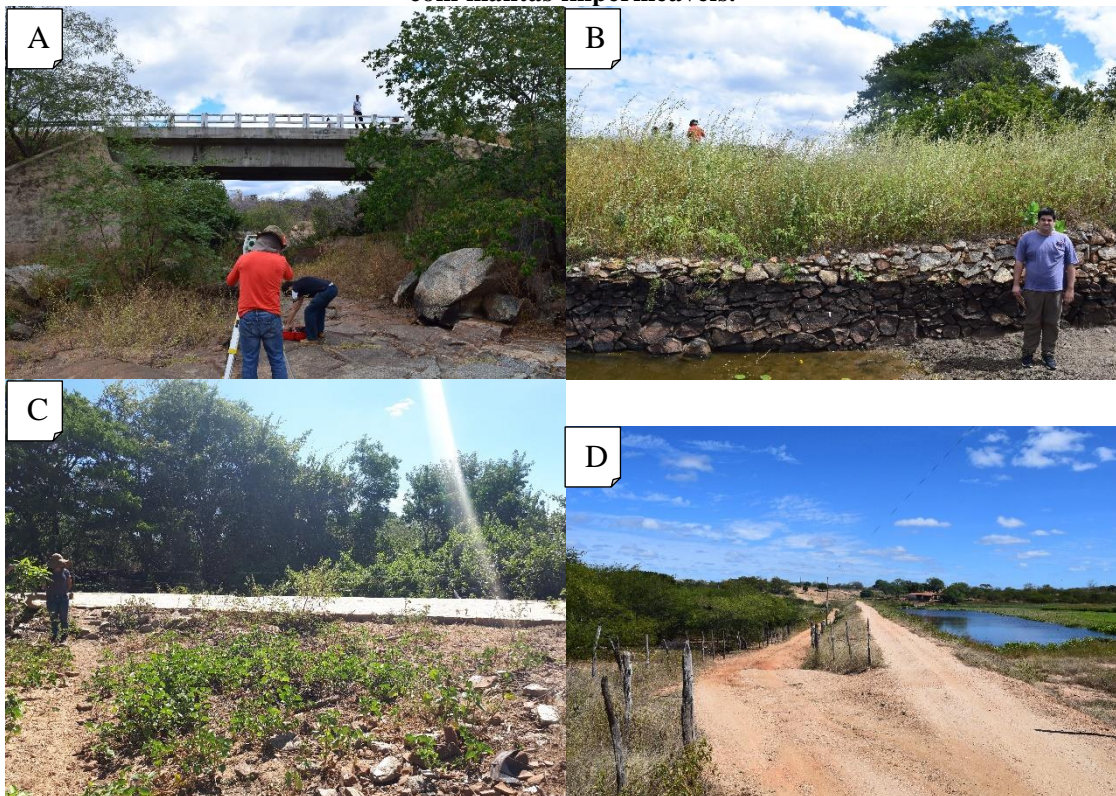
Figura 7. A – Ponte de concreto sobre leito rochoso de canal intermitente, com constrição de vale fluvial; B - Barragem rústica com estrutura de blocos encaixadas e terra; C - Passagem molhada de blocos e cimentos em estrada rural; D - Barragem rústica com balde de terra com mantas impermeáveis.
