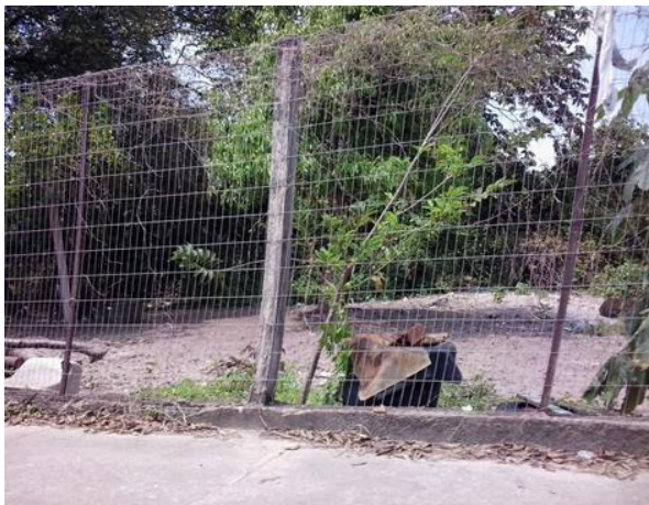
Figura 16: Cercamento da lateral Norte do PNMC. Fonte: Trabalho de campo realizado pelo autor da pesquisa, em março de 2015.
