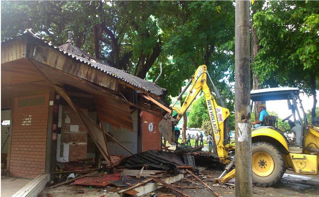
Figura 4: Momento da demolição das primeiras barracas 28/07/2015. Foto do autor
