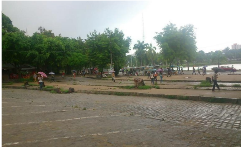
Figura 6: Árvores cortadas para dar lugar à nova pista do BRT, deixando a população sem o conforto na parada dos ônibus, julho de 2015. Foto do autor.
