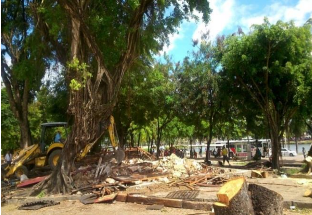
Figura 13: Retirada dos entulhos e troncos de árvores jovens. Fotodo autor em 28/08/2015
