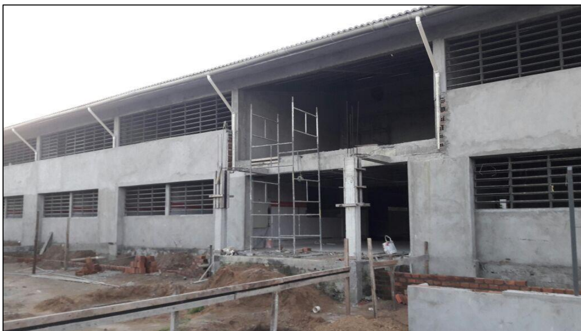
FIGURA 4 – ESCOLA ESTÁ SENDO CONSTRUÍDA NO LOTEAMENTO
