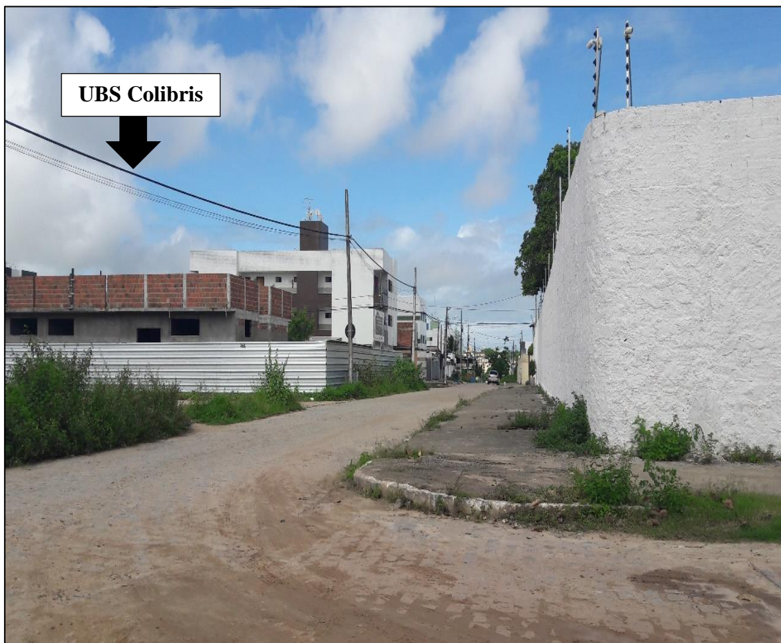
Figura 27 – Fotografia da Unidade Básica de Saúde - UBS Colibris em construção
