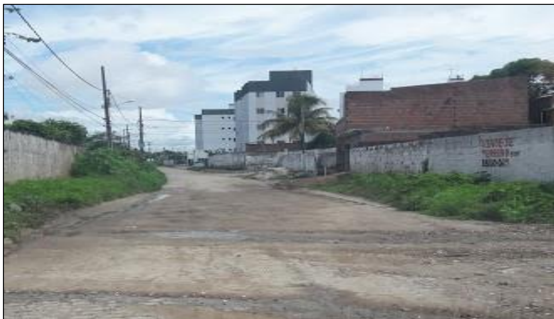
Figura 2 – Rua Ciro Trocolli com a Josefa Pontes Cesar com o acúmulo de entulho
