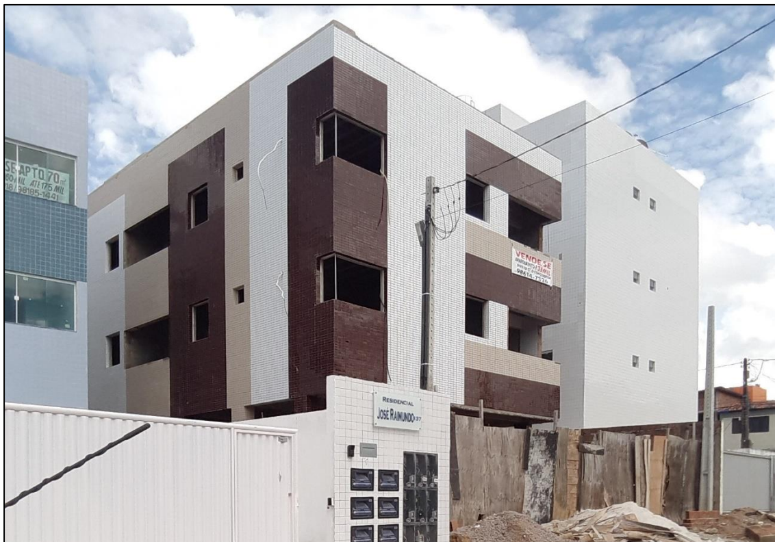
Figura 18 – Residencial José Raimundo em fase de acabamento.
