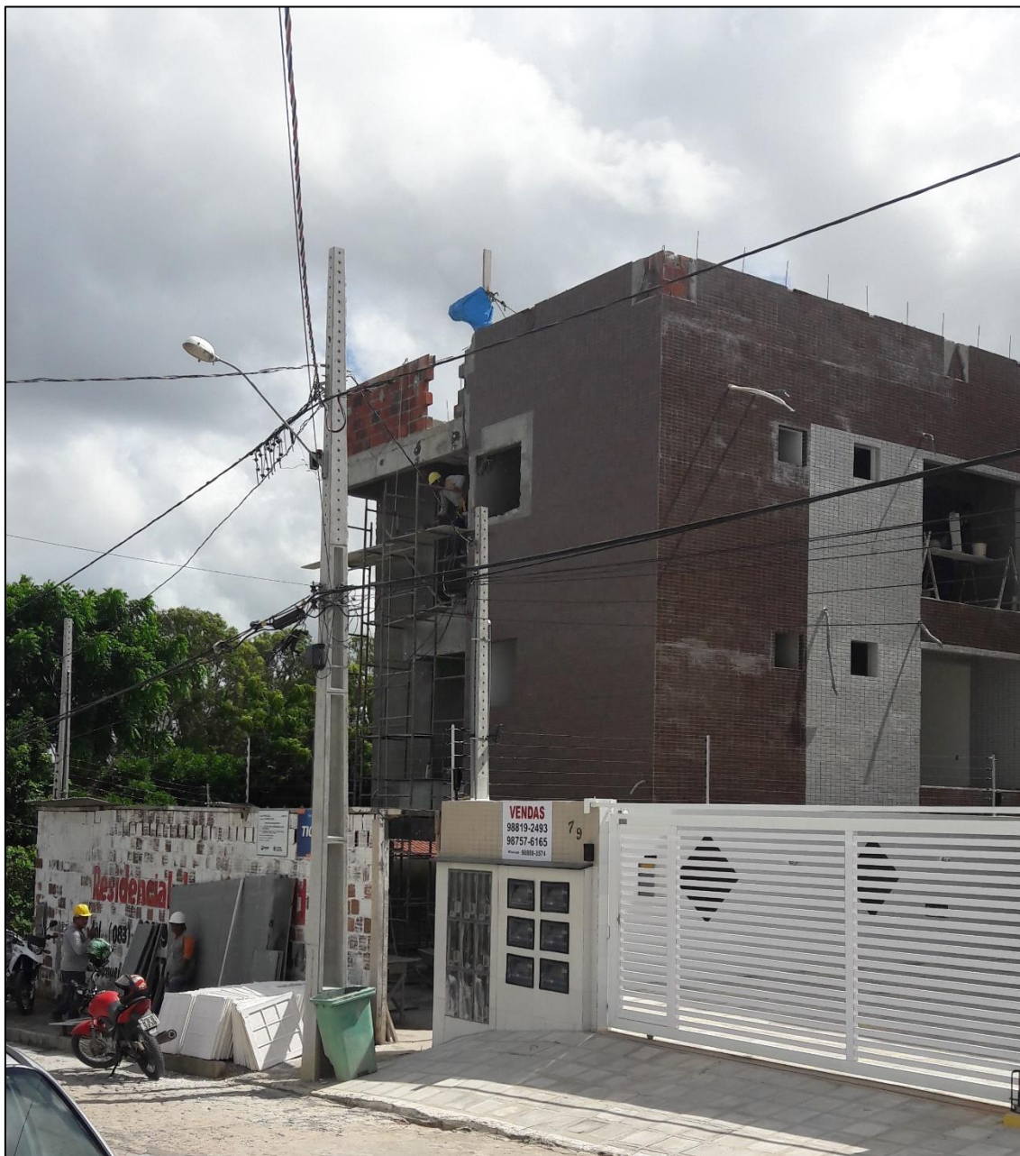
Figura 21 – Residencial Jeová Jirê 12 com obras aceleradas
