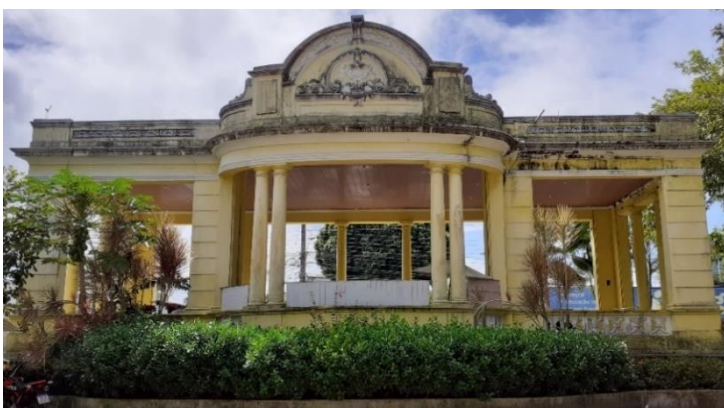
Figura 46. Coreto da Praça da Independência: fachada sul
