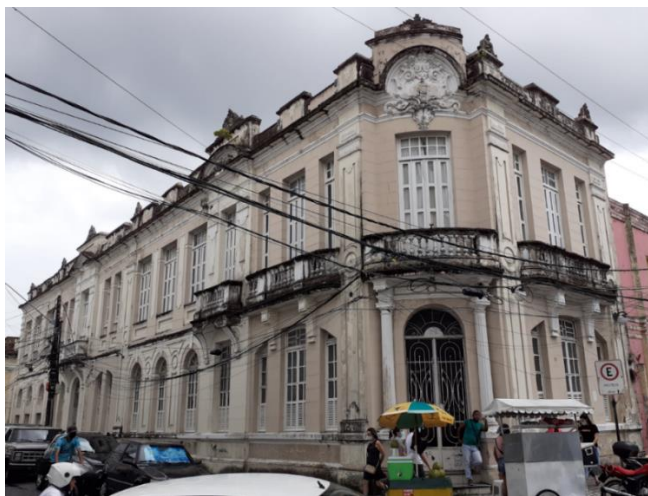
Figura 25: Edifício Sede da FUNJOPE, Rua Duque de Caxias
