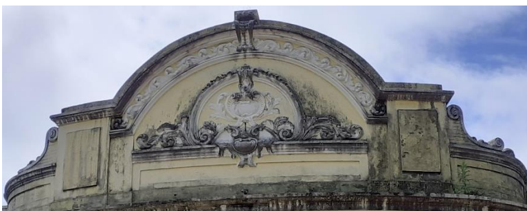
Figura 48. Frontão da porção central da edificação
