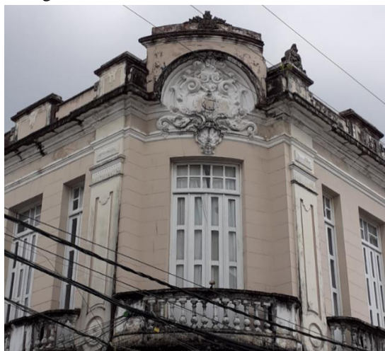
Figura 26: Detalhe do ornamento da porção diagonal da frontaria
