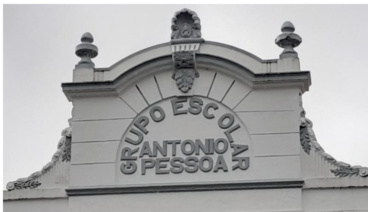
Figura 40. Detalhe do frontão da edificação.
