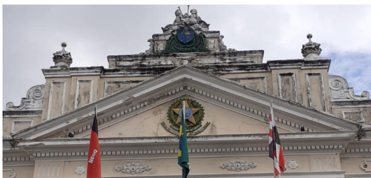
Figura 9. Porção central da platibanda
