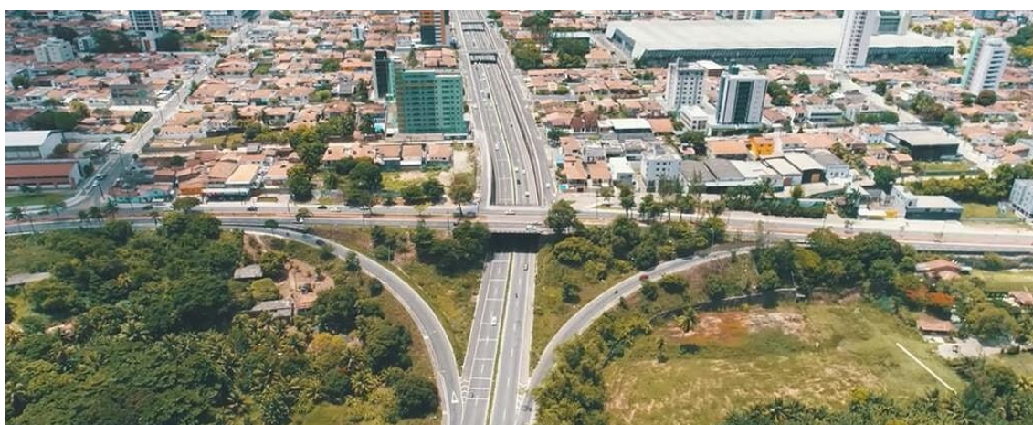
Figura 6: Ruptura na malha urbana do bairro de Tambauzinho ocasionada pela BR 230 e o Espaço Cultural José Lins do Rêgo ao fundo. Fonte: Tácio Adventures
