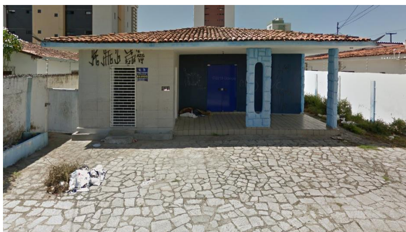
Figura 12: Imóvel abandonado na Rua Dep. Jáder de Medeiros. Fonte: Google Maps
