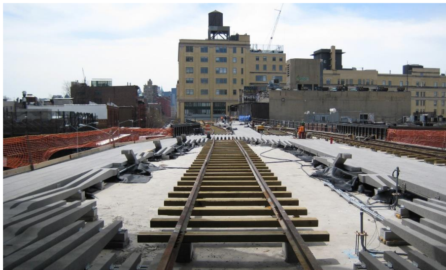
Figura 6 Construção do piso de concreto - Fonte: Friends of High Line Org
