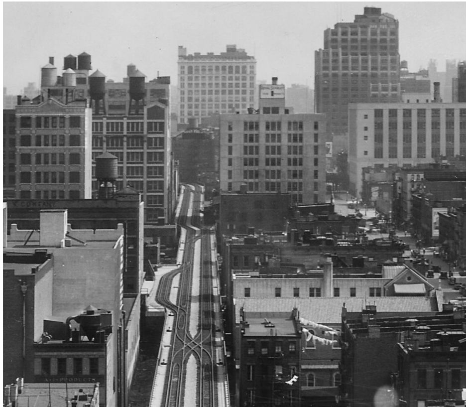
Figura 1 Linha férrea onde o parque foi construído - Fonte: Friends of High Line Org
