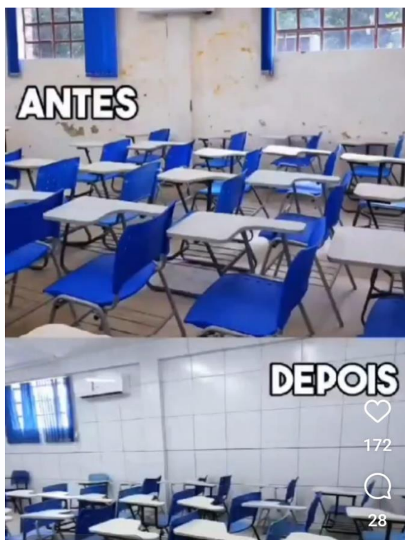
Figura 12. Obra na central de Aulas de Rio Tinto.
