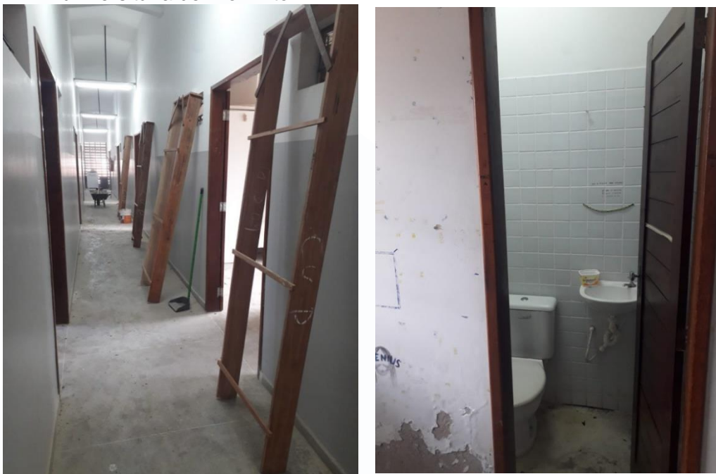
Figura 13. Obra de manutenção da infraestrutura da residência universitária de Rio Tinto.
