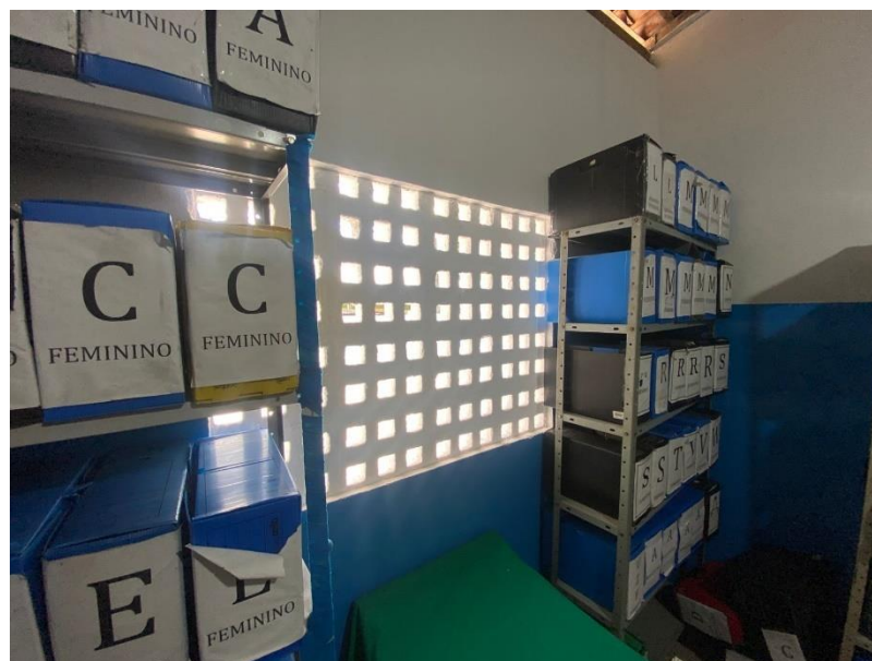
Figura 13. Estantes local indevido.
