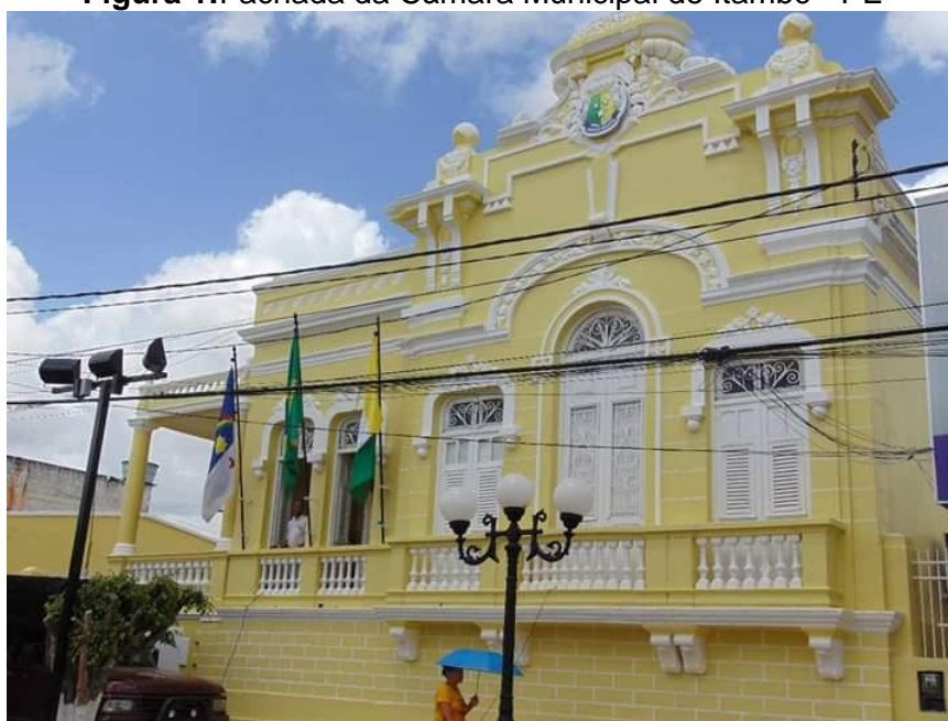
Figura 1: Fachada da Câmara Municipal de Itambé - PE
